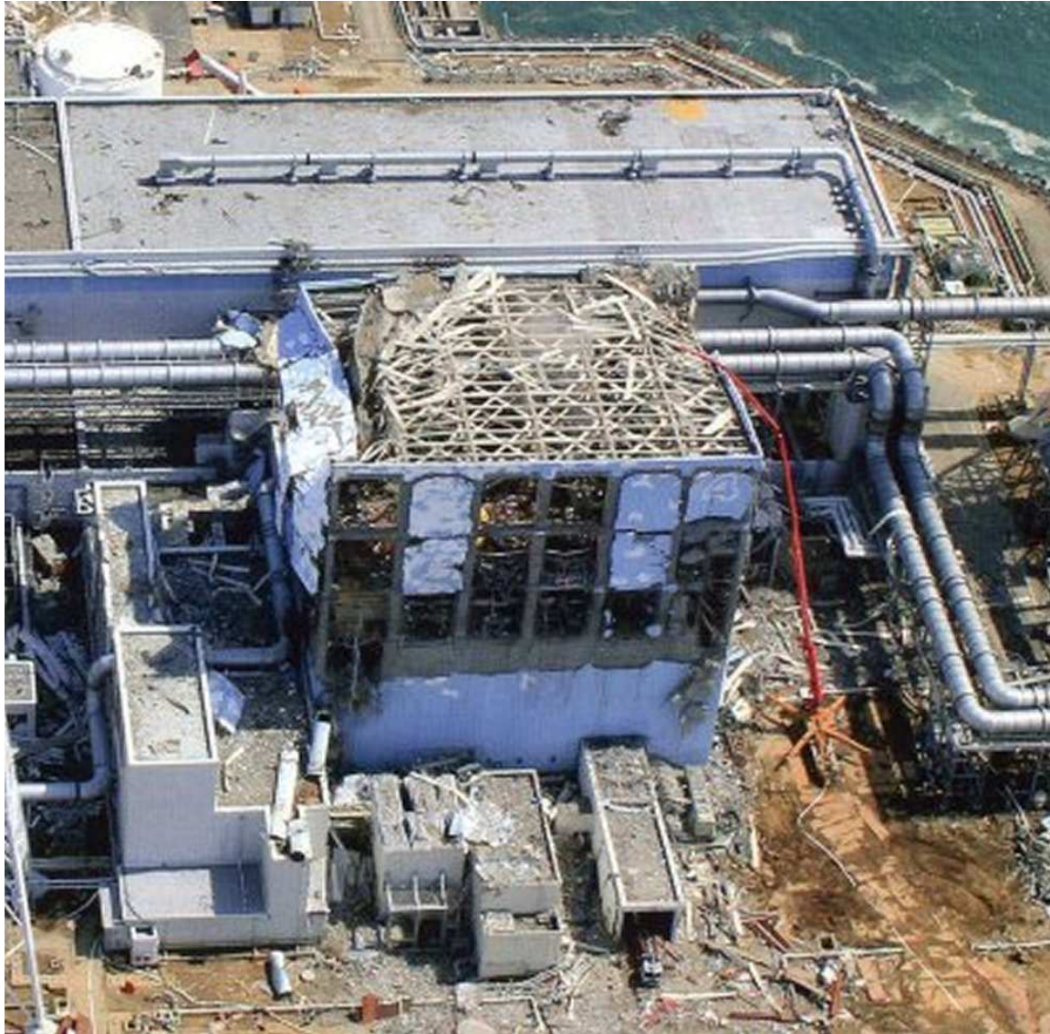
Kühlung des Blocks 4 mit Wasser, das ein Lkw aufs Dach des zerstörten Gebäudes pumpt
